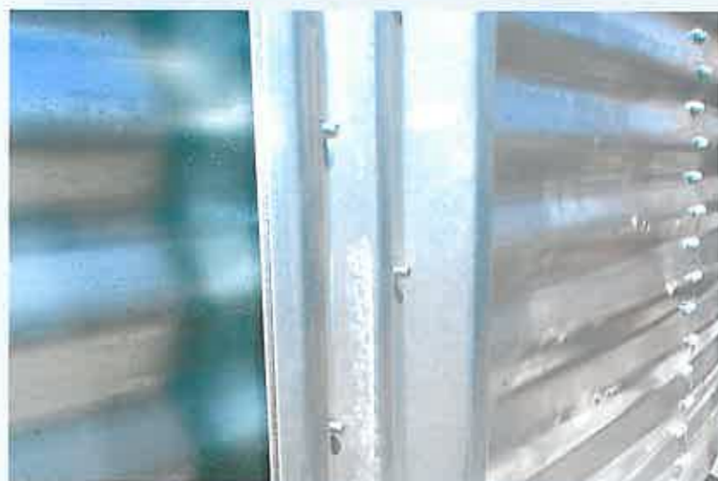
W-образное ребро жесткости и волнистая конструкция боковых стен зернохранилища
