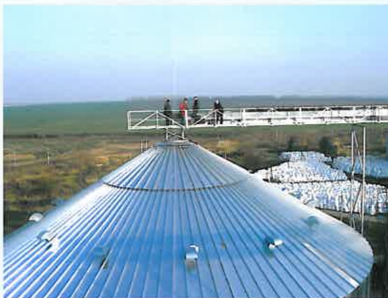
Конструкция крыши зернохранилища
